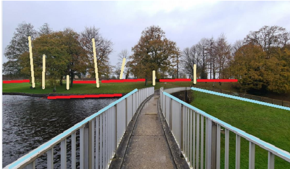
Vue de la passerelle du barrage
